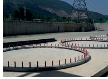
Silo Temel Çalışması
