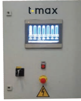
Silo Seviye Kontrolü ve İzlenebilir Dokunmatik Paneller
