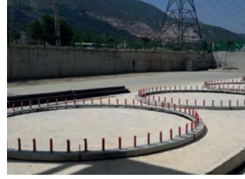
Silo Temel alıřması
