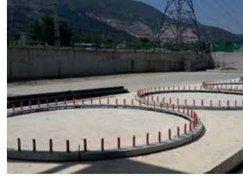
Silo Temel Çalışması
