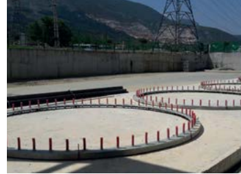
Silo Temel Çalışması
